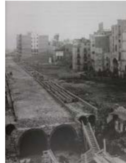
Finalització tram inferior túnels i galeries
