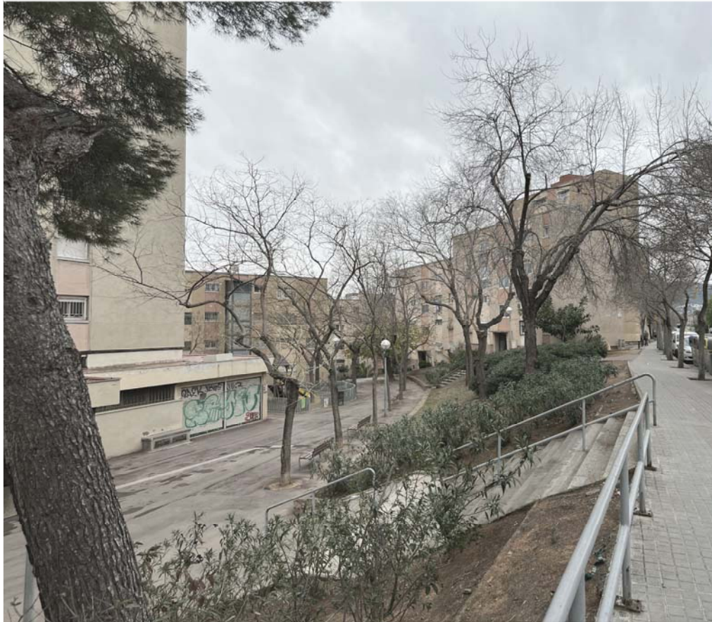
TALUSOS AMB FORT PENDENT
