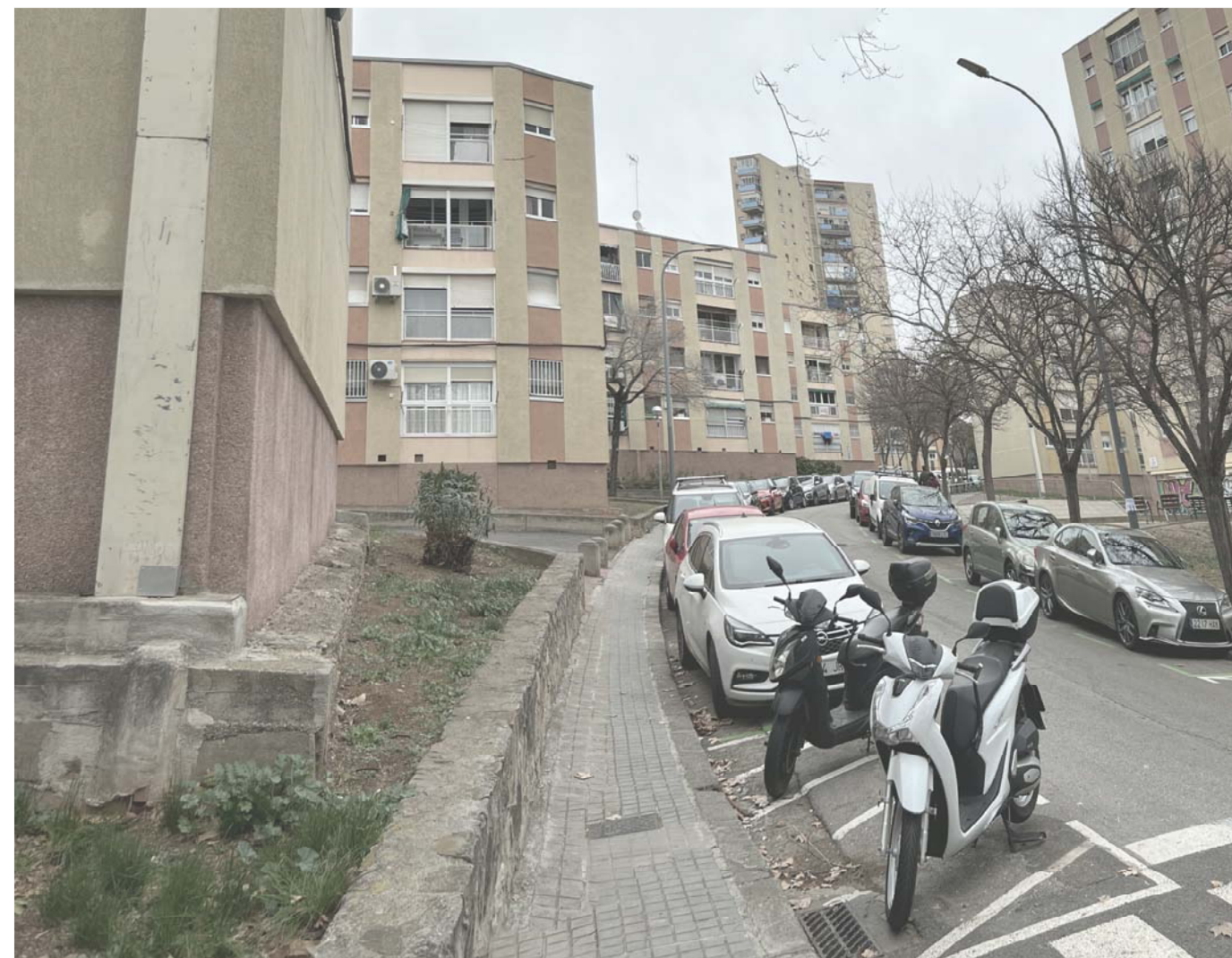
VORERA ESTRETA I AMB FORT PENDENT TRANSVERSAL
