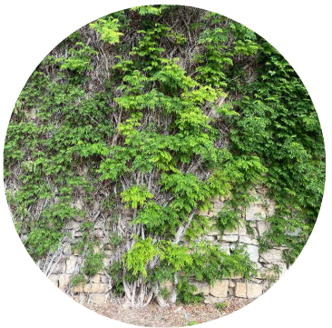
Cobrint de murs amb vegetació
