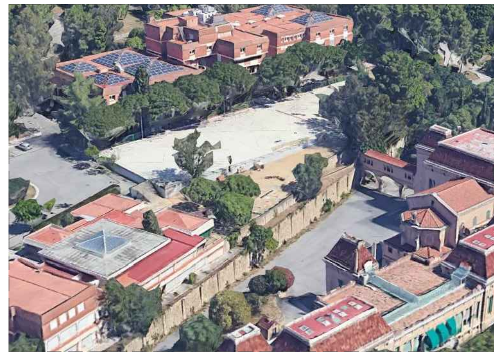
VISTA D'EDIFICI A INTERVENIR
