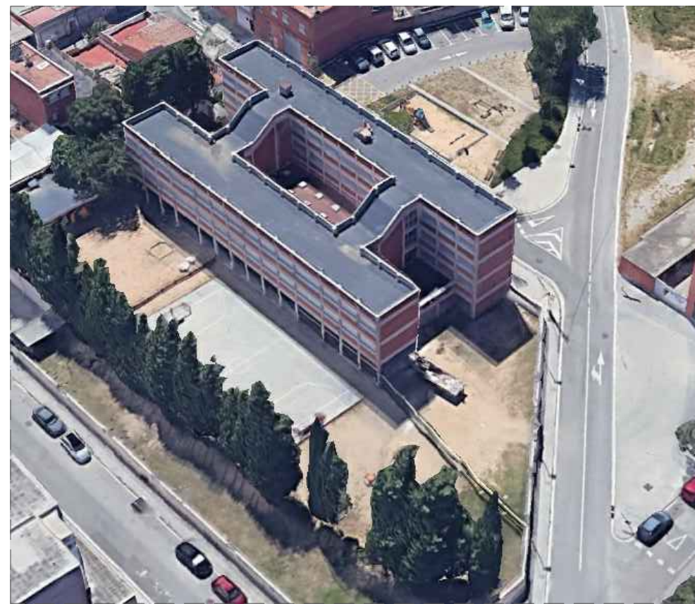
VISTA D'EDIFICI A INTERVENIR
