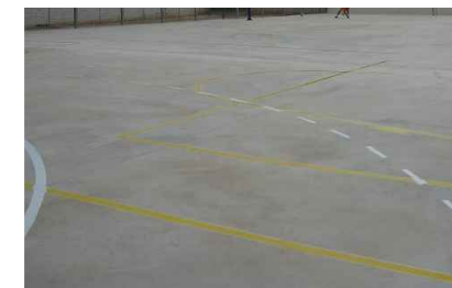
04 - PINTAT DE LÍNIES PISTA 06 - NOVES CISTELLES
