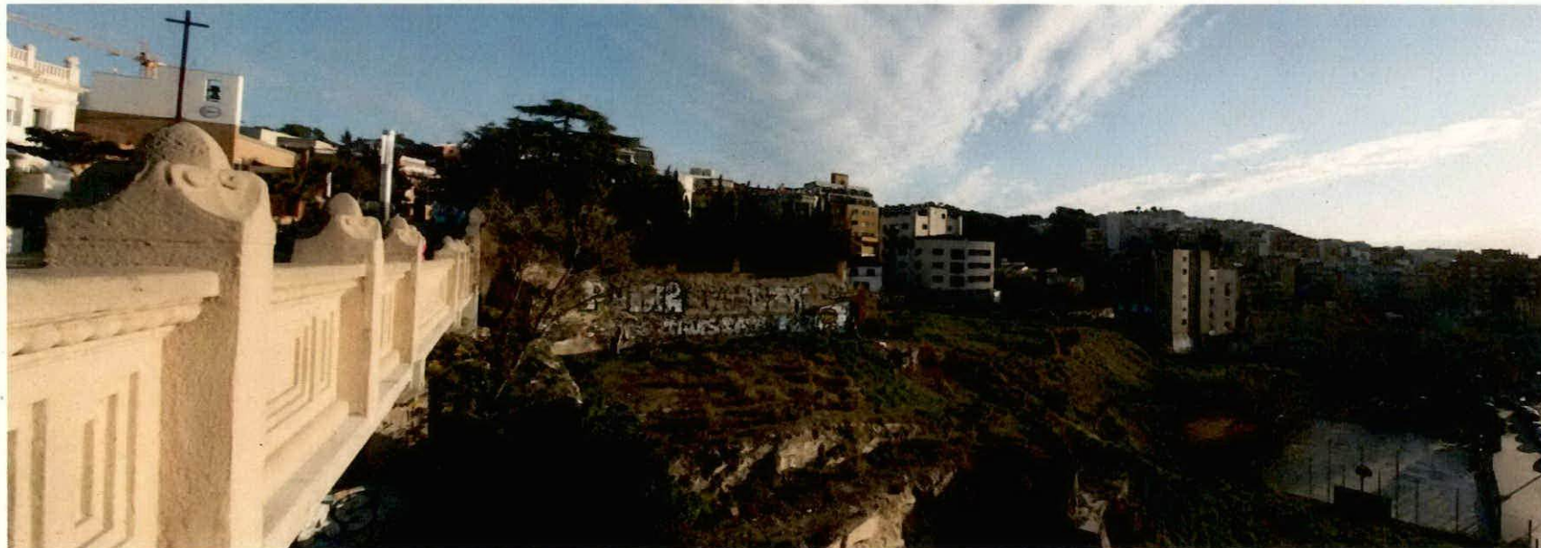
14. Vista de l'àmbit UA6-UA4 des del Viaducte de Vallcarca
