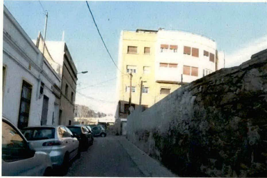
1. Carrer de de Calendau amb el mur límit de la UA3
