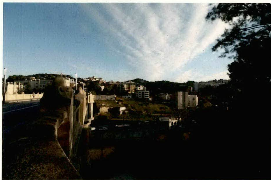
16. Vista de l'alçat de l'àmbit UA6-UA4 des del Viaducte de Vallcarca
